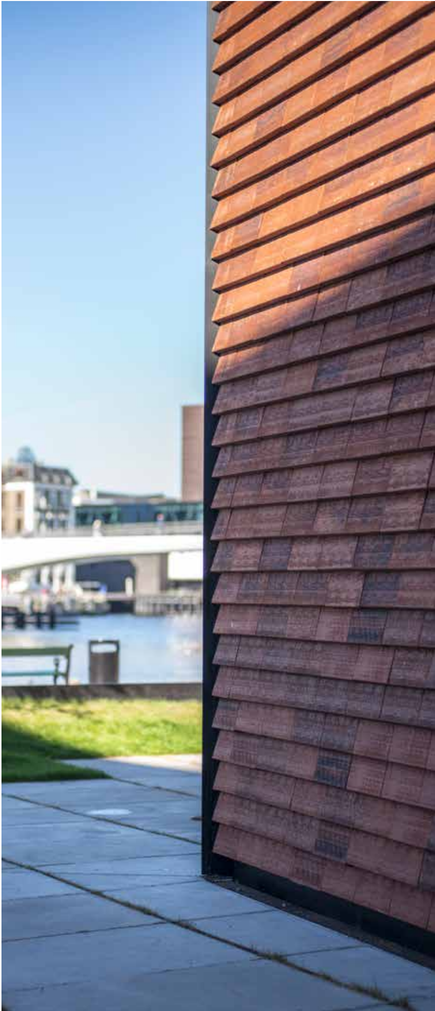
Skråhjørne med avslutningsprofil
