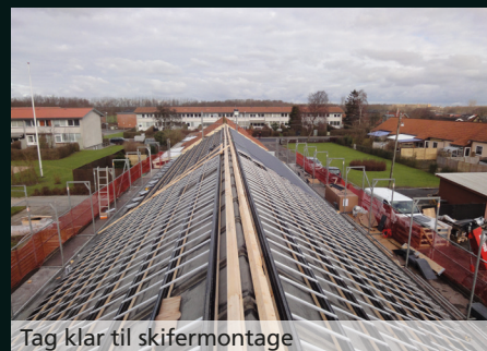
Forbindelseskanaler i aluminium monteres på lægtesystem
