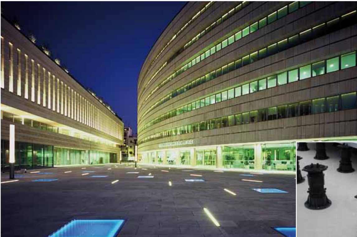
Terrasse på sokler med steinheller som toppdekke
