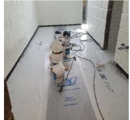
Beskyttelse av fliselagt gulv
