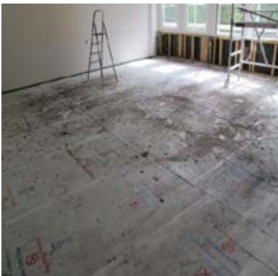
Beskyttelse av gulv ved rehabilitering
