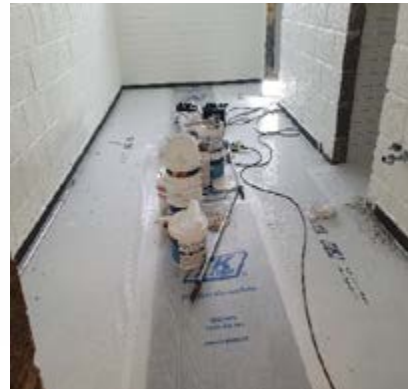
Beskyttelse av fliselagt gulv
