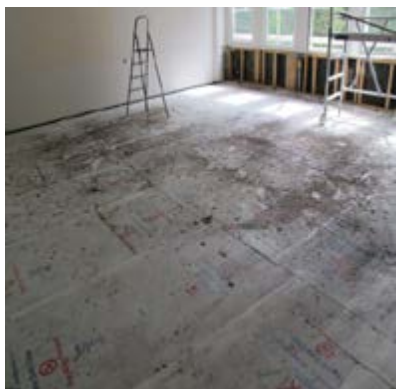
Beskyttelse av gulv ved rehabilitering
