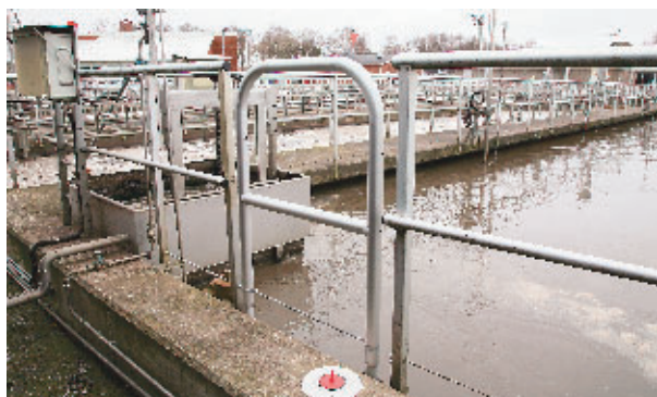
Modulrekkverksseksjon som grind ved renseanlegg.
