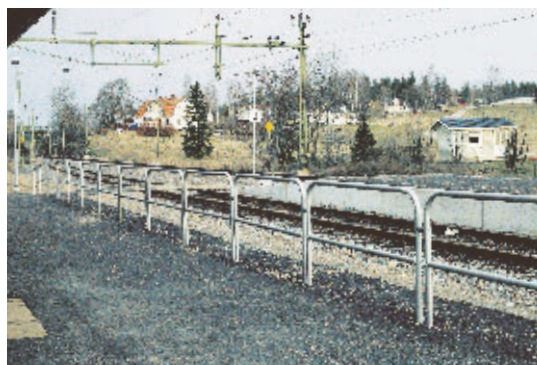
Modulrekkverk som sperring mot toglinje.
