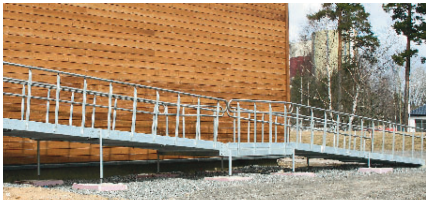
Rekkverksstenderne boltes fast i vangen.
