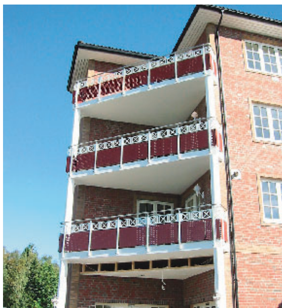
Seksjonsrekkverk med fylling av perforerte plater og dekorative krysstag.
